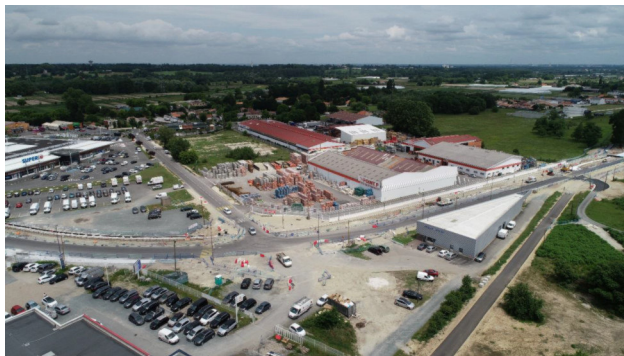
Source : photo La Fab
